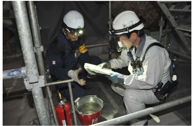
防火対策施工後の立会確認の様子
