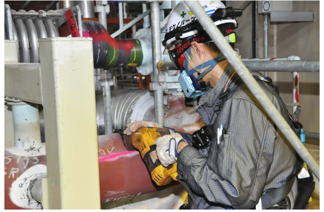
給水加熱器周辺の配管切断の様子
