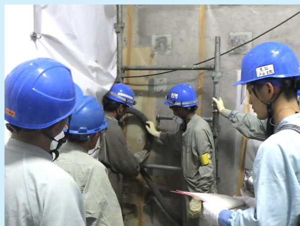
防塵作業ハウス設置後の立会確認の様子
