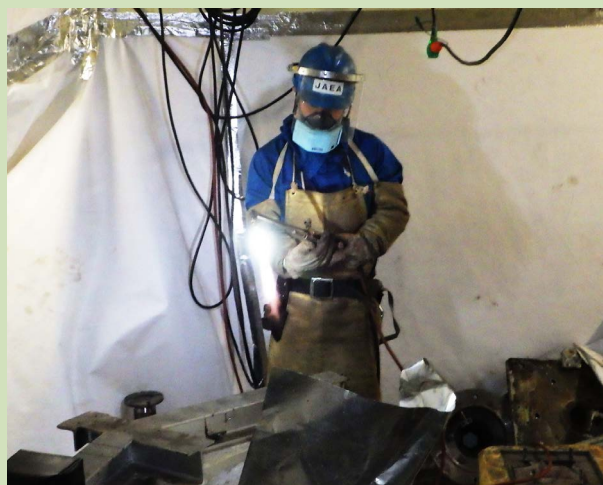
ガス溶断作業
