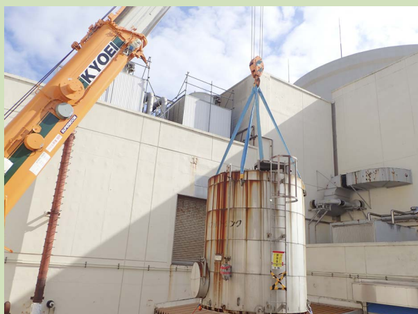
クレーンによる重量物(アスファルトタンク)の吊上げ
