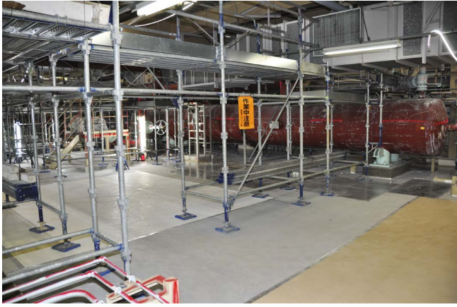
給水加熱器作業エリアの養生、足場を設置
